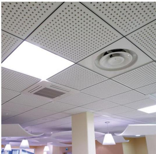
Le décor Regula correspond à une dalle non perforée disponible dans tous les usinages de bords. Il permet la réalisation de calepinages rythmés alternant zones perforées et non perforées. Le décor Regula est également conseillé pour les coupes de rives et les dalles intégrant des appareillages (luminaires, signalétiques...).
